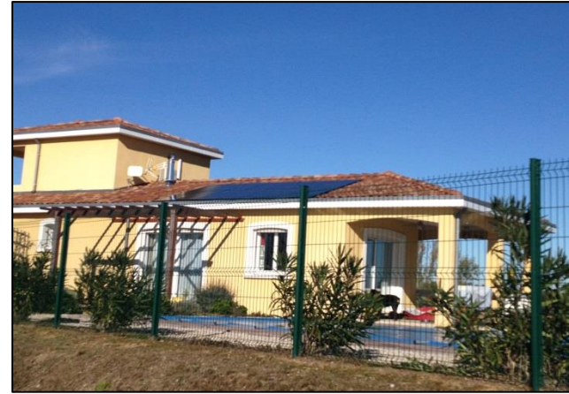
Intégration de panneaux solaires en toiture
