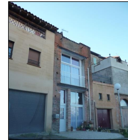
Travaux de réhabilitation, Bourg de Saint-Ybars. © UrbaDoc 2013
