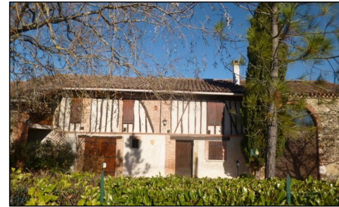
Réhabilitation du corps de ferme
