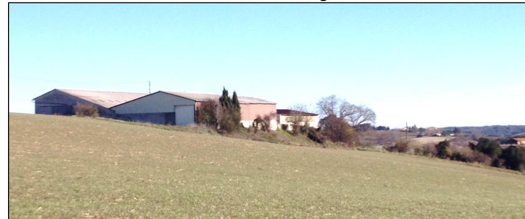
Bâtiments d'activité agricole :
