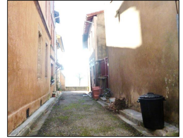
Présence de trottoirs bilatéraux impraticables au niveau de la Bastide
