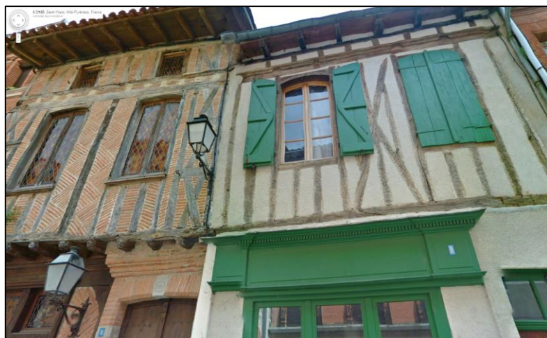
Utilisation du bois comme matériau de construction avec briques enduites ou non. Rue mage d'en haut.
