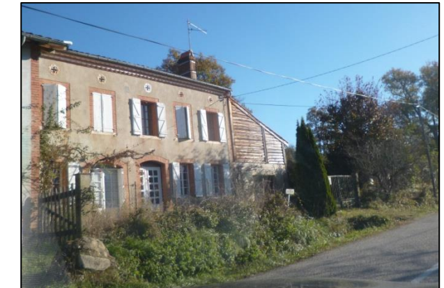
Bâti traditionnel avec extension en bois
