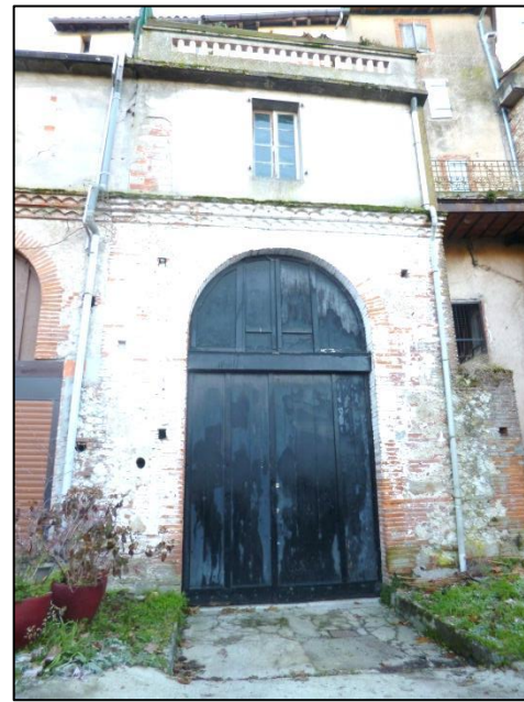
Bâtisse se caractérisant par une déclinaison des ouvertures en fonction d'usage distincts ; Encadrement des ouvertures souligné par l'utilisation de briques © UrbaDoc, 2013
