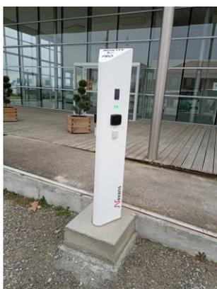
Cependant pour des raisons budgétaires, le SDE09 n'a pas souhaité intégrer la borne de Saint-Ybars dans le réseau RÉVEO. La borne installée ne dispose pas de dispositif de comptage de l'énergie consommée et ne dispose pas non plus de moyen de règlement directement sur la borne. Le fonctionnement de la borne se fait au moyen de badges qui sont à disposition à la mairie.
